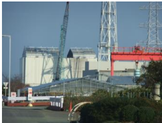
1号機原子炉建屋屋根
